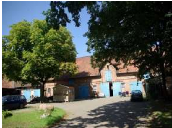
Abb. 4-8 Dreiseitige Hofanlage mit Hofbaum
