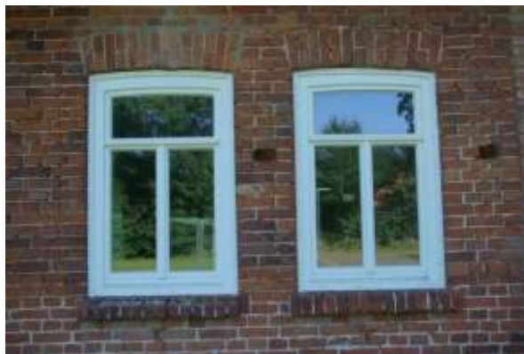
Abb. 7-11 Erneuerte Fenster in Ziegeleigebäude
