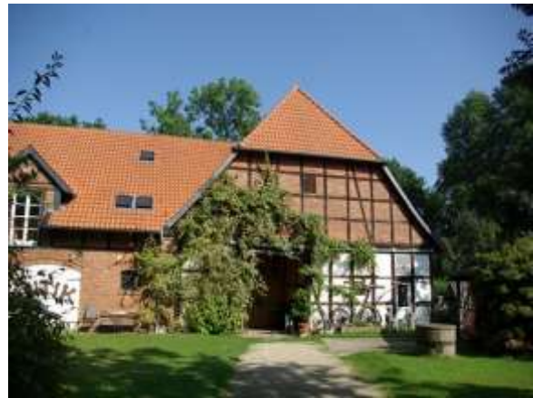
Abb. 4-10 Wohnwirtschaftsgebäude in Sievershausen
