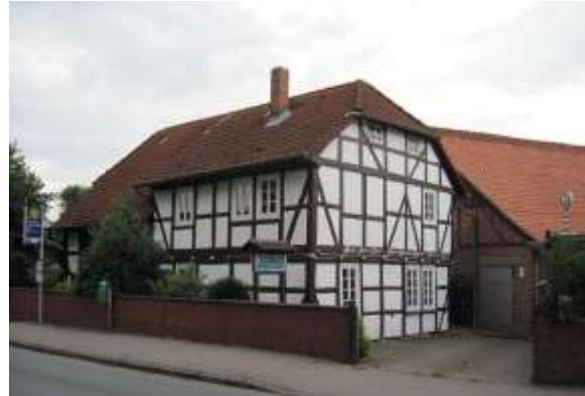
Abb. 7-7 Fachwerk mit verputzten Gefachen
