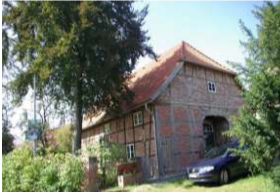
Abb. 7-6 Fachwerk mit Ziegelausmauerung
