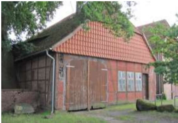
Abb. 7-8 Hangziegel als Wetterschutz
